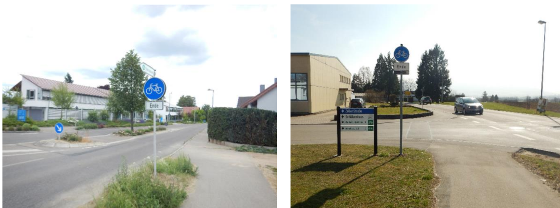
Abbildung 17: Fehlende Überführung zwischen Radweg und Fahrbahn in Wolfschlugen (links) und in Holzmaden (rechts)
