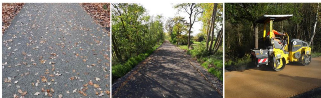
Abbildung 16: Asphaltähnliche Deckschichten aus Gemisch von Basaltstein und Spezialsanden / heller Split-Mastix-Asphalt
